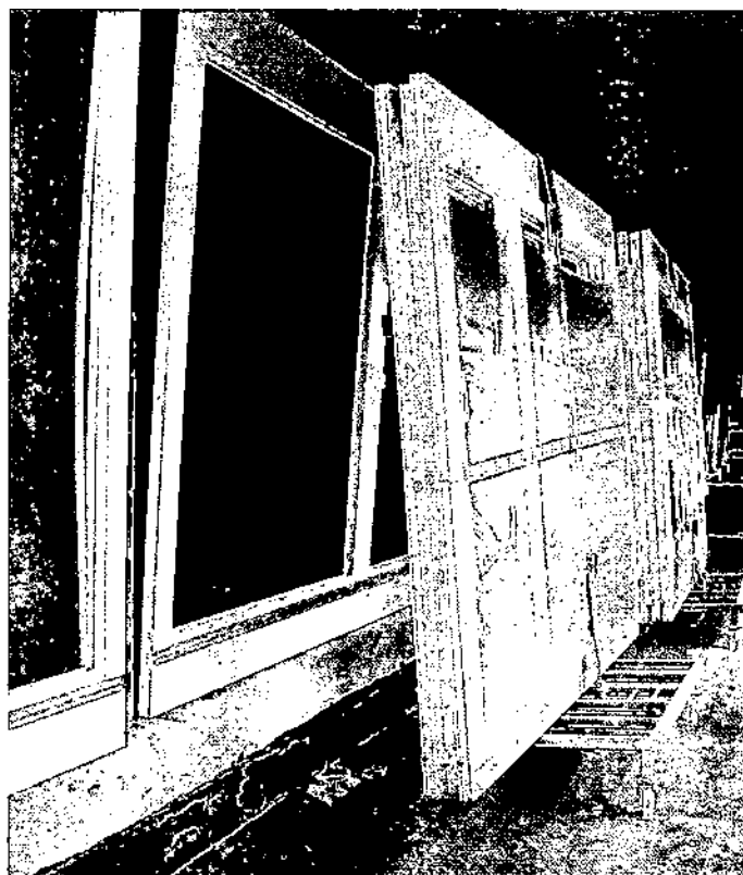
Fenstermontage auf der Baustelle (Abb.6)
