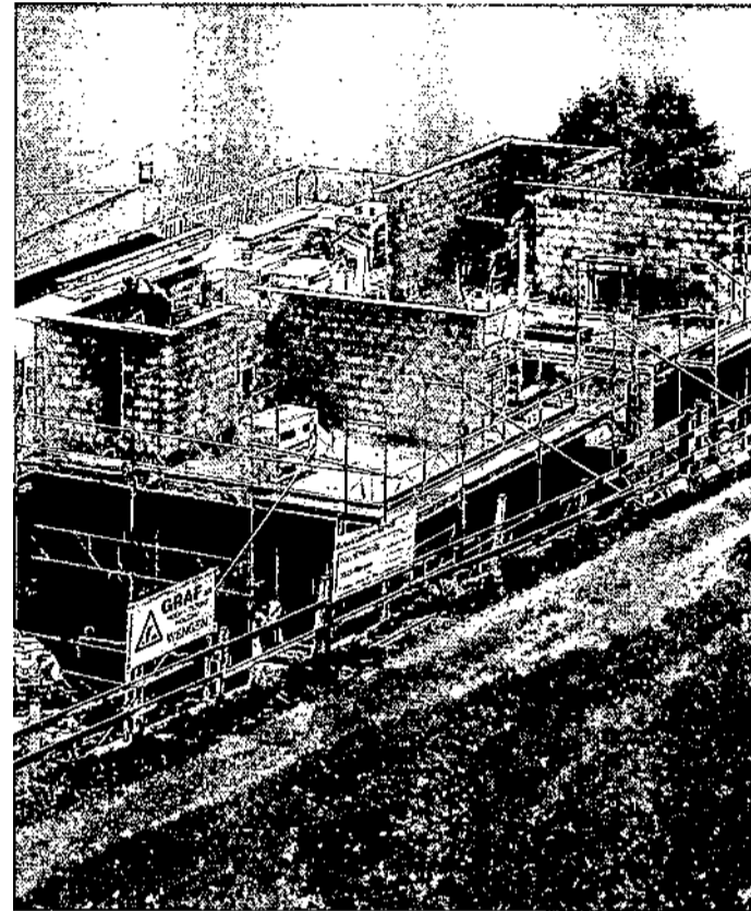
Massivbau im Rohbaustadium (Abb.6)
