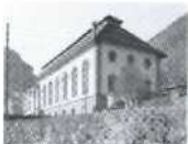
S.63 Tully, Wallis 1914, ausser Dienst, energie ouest suisse (eos)
